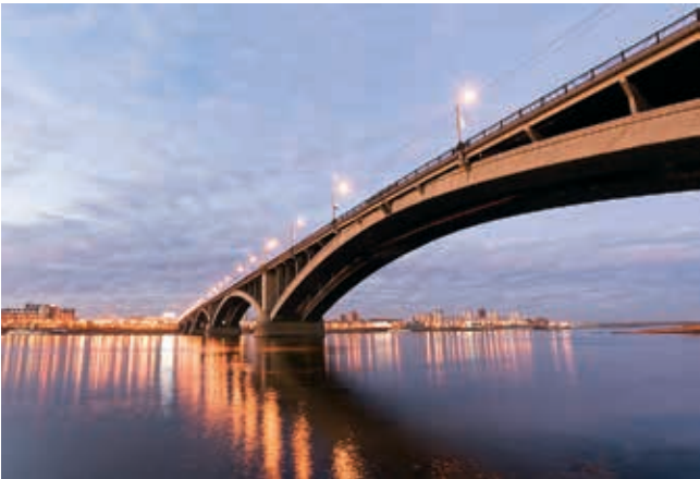
Коммунальный мост, г. Красноярск
